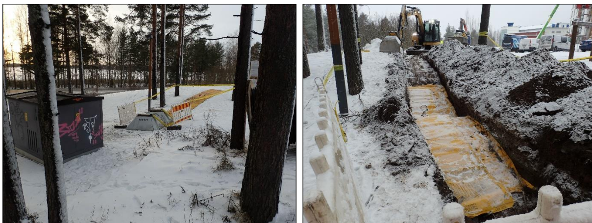
Vasen: muuntamokopin länsipuolella (kuvassa oikealla puolella) näkyy kaksi säteilylämmittintä sekä routamatot, jotka sulattivat jäisen maan ennen tutkimuksia. Lounaaseen. Oikea: routamatot pitivät avatun kaivannon sulana öisin. Länteen.
